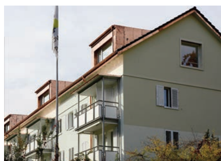
Dachwohnungen anstelle von Estrichen
