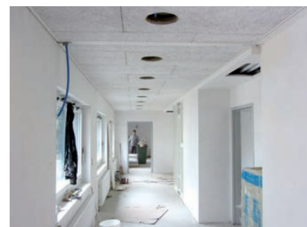
Die letzten Arbeiten sind im Gange
