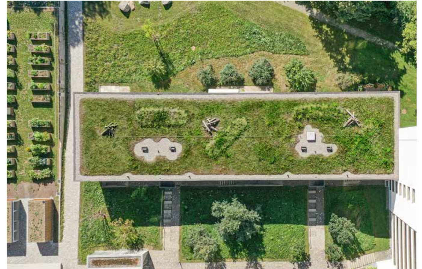
Biodiversität geht bei der GEWO BAG hoch hinaus: extensiv begrünte Dachfläche an der Konrad-Ilg-Strasse 9/11 in Höngg-Frankental. Mit höherer Substratstärke für besser und grösser wachsende Pflanzen sowie aufgeschichtetem Totholz als Lebensraum für Insekten.
