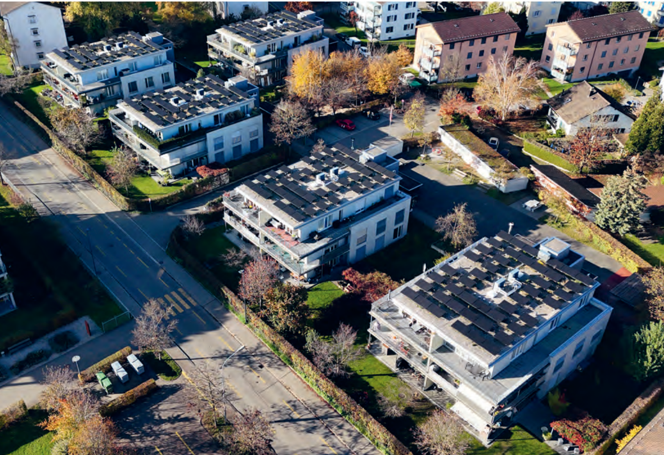
Die nachgerüsteten PV-Module in der Siedlung Brandgrubenstrasse in Uster.
