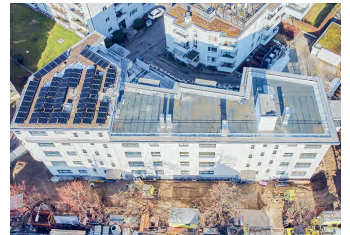
Optimal genutzte Dachfläche mit Photovoltaik und noch entstehenden Mietergärten an der Fellenbergstrasse 290/292.
