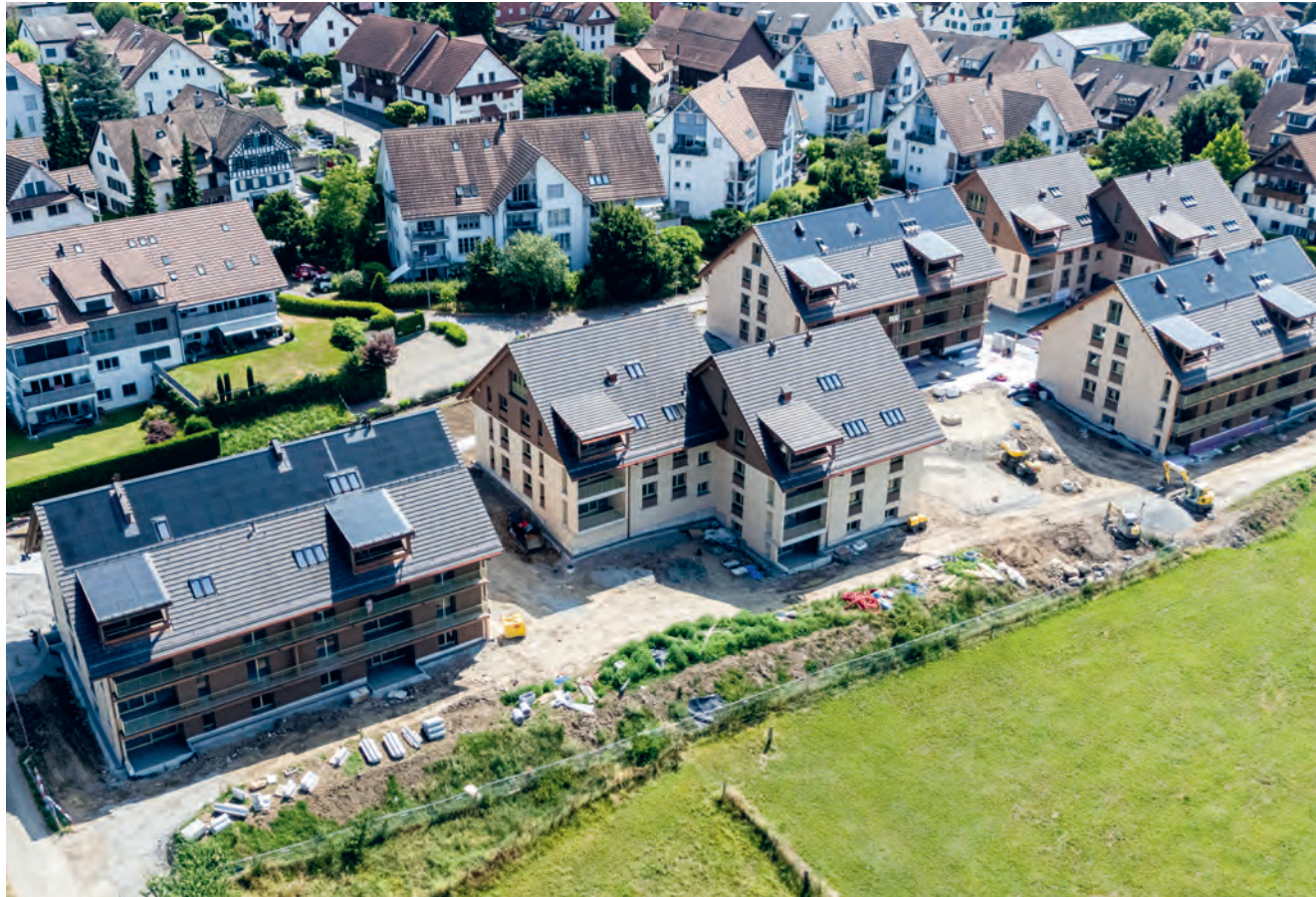
In der Kernzone werden heute im Rahmen der Baubewilligung integrierte Solarsysteme verlangt (Beispiel: Im Weierächer in Wettswil am Albis). Sie sind teurer, fügen sich jedoch besser in die bestehende Dachlandschaft ein.
