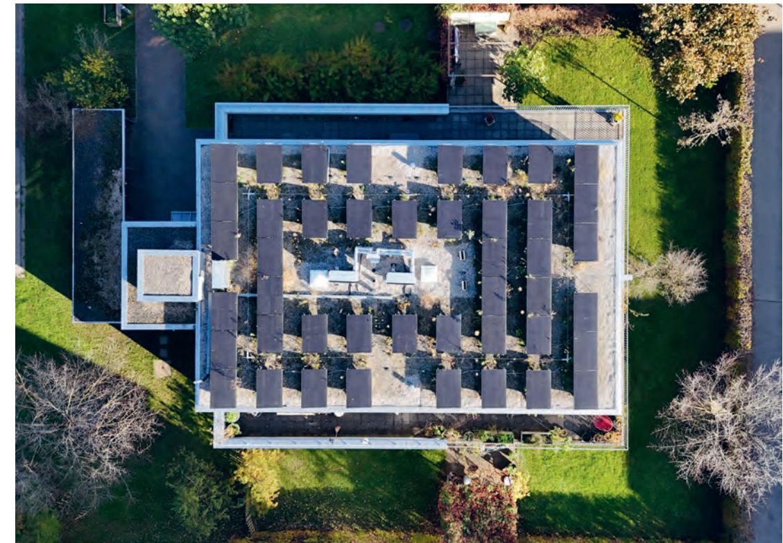
Photovoltaik-Dachanlage der neuesten Generation an der Brandgrubenstrasse in Uster.
