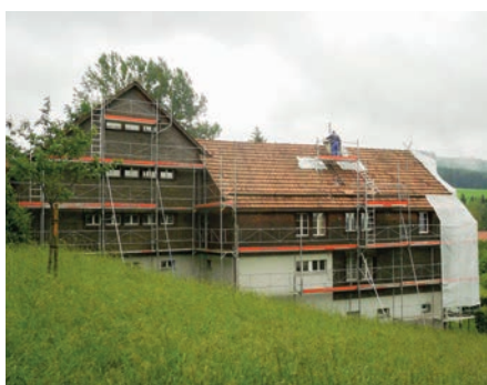
Die Sanierung des Hauses «Yambhu Lagang» ist bald abgeschlossen.
