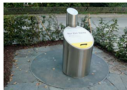
Eine saubere Sache: Unterflur-Container
